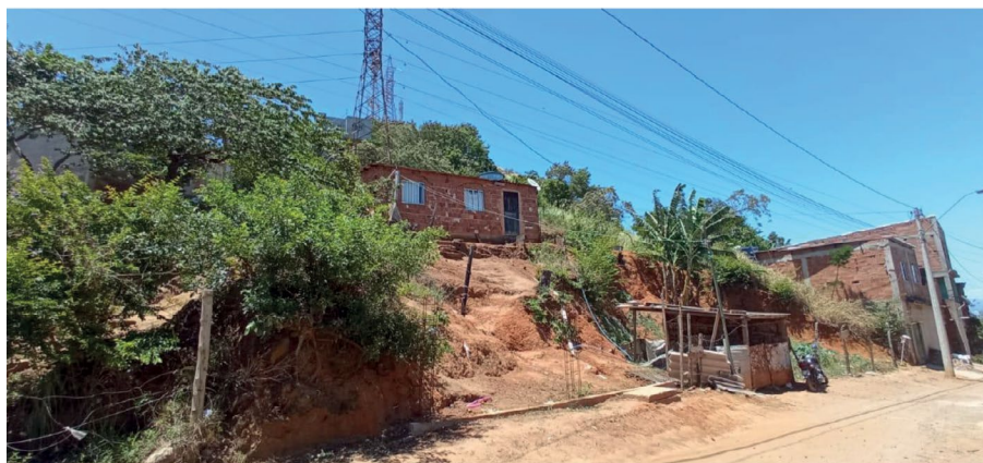
Figura 4 – Assentamentos precários no Morro do Jaburuna
