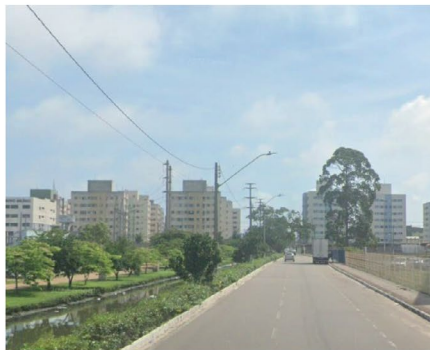
Figura 6 – Falta de calçada ao lado do Canal
