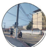
3) Fachada ativa comércio, escola, porém calçada em más condições. Sinal comportamental de pinturas 'grafite' nos muros.
