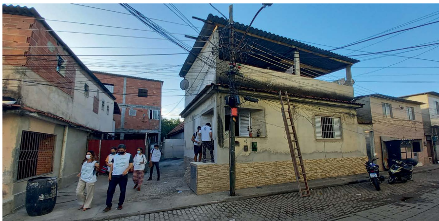
Figura 13 – Habitação unifamiliar de único pavimento Imagem da residência vista da rua
