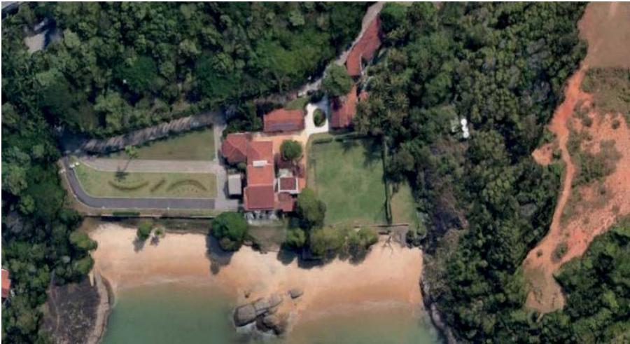
Figura 3 – Visão geral das edificações existente
